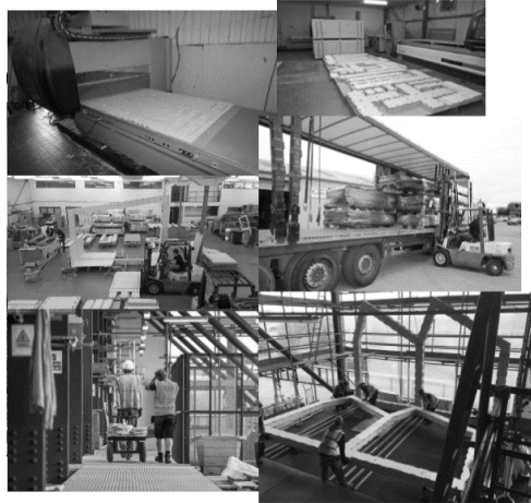
Şekil 2. WikiHouse üretim, taşıma ve uygulama süreci (Kaynak: WikiHouse Version 1.0, 2019).
