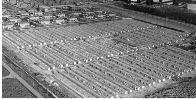
Şekil 1. Van depremi sonrasında geçici barınma amacıyla kurulan konteynerlar (Kaynak: AFAD, 2021).
